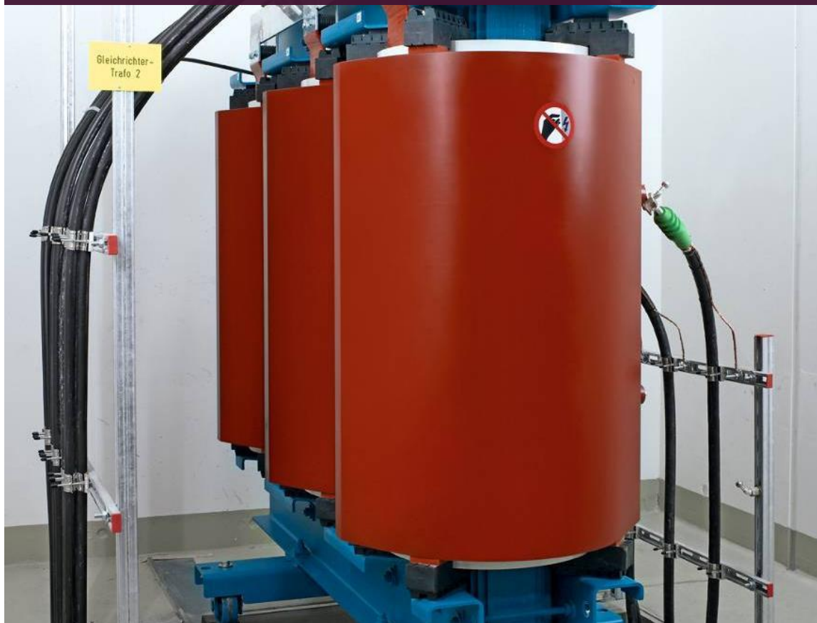
Műgyanta kiöntésű transzformátor GEA FOL®
