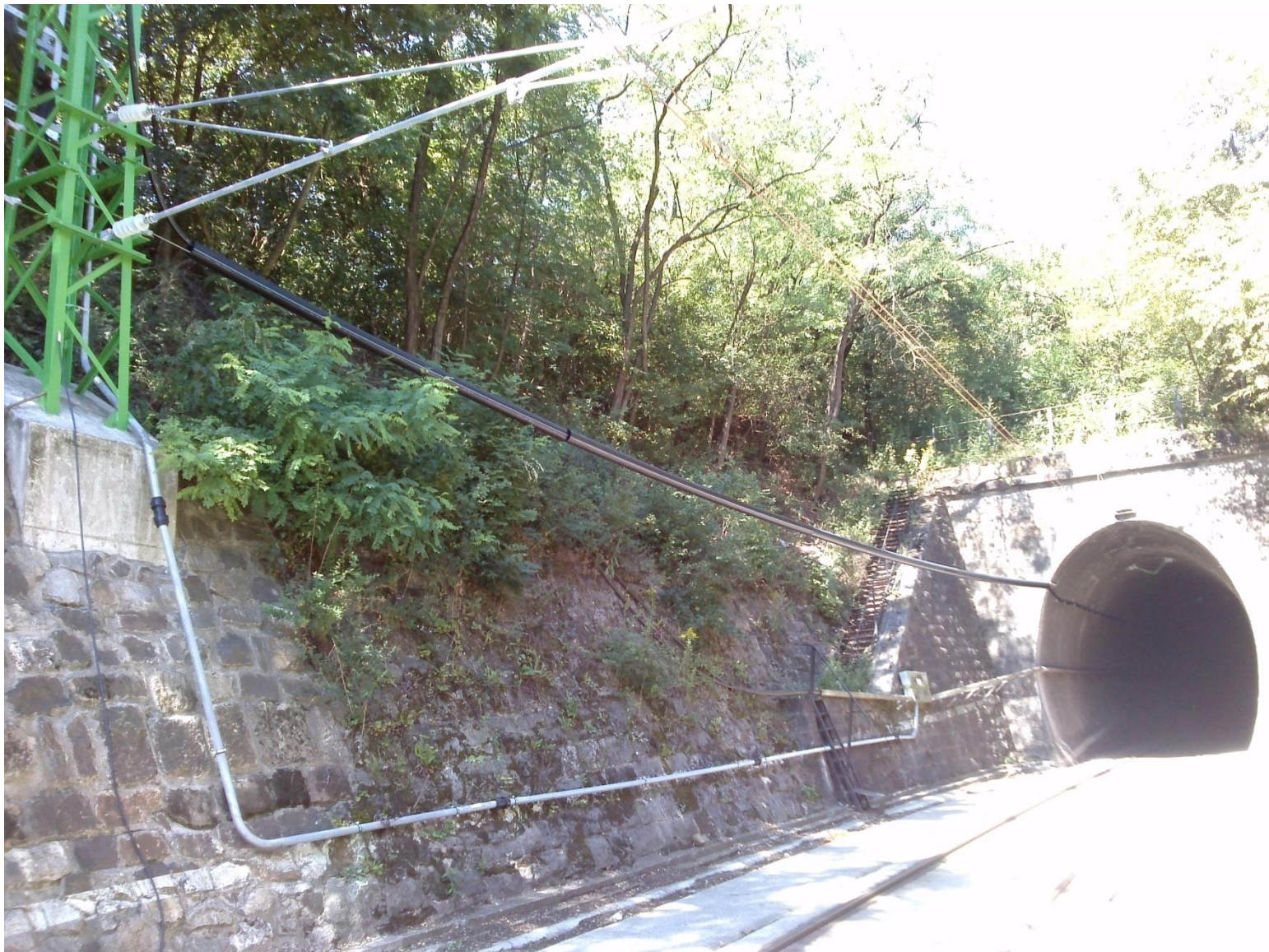
A hosszlánc és a kábelek bevezetése a Pilisvörösvár – Piliscsaba alagút torkolatában
