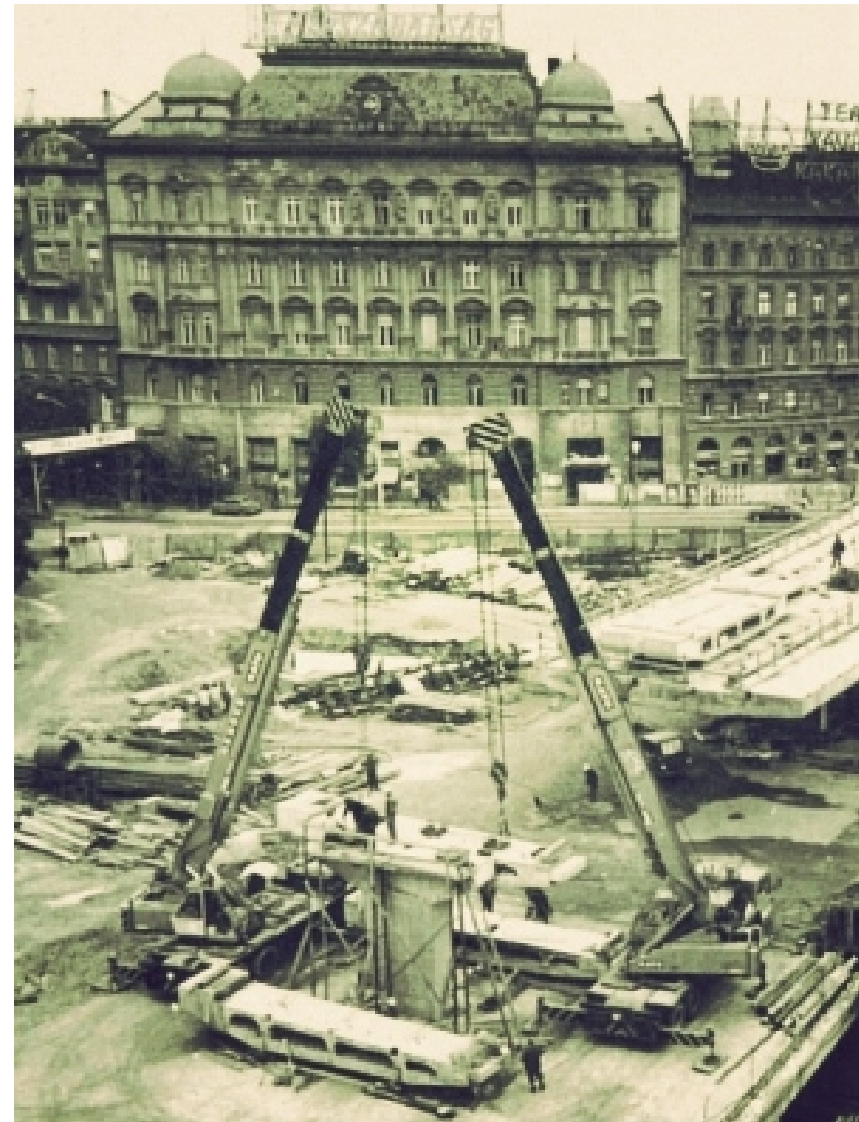
Szerelési ág első elemének felhelyezése
