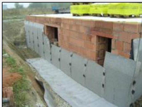
Függőleges, talajjal érintkező szerkezetek
