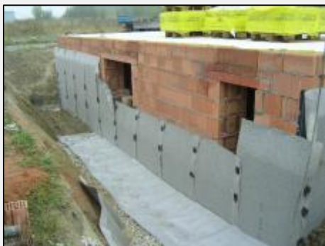
Függőleges, talajjal érintkező szerkezetek
