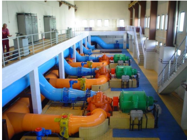
4 db 250kVA-es kaszkád hajtás - Fővárosi Vízművek Zrt., Ráckeve
