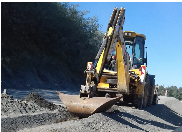
Leterhelő árok kiásása árokászó munkagéppel
