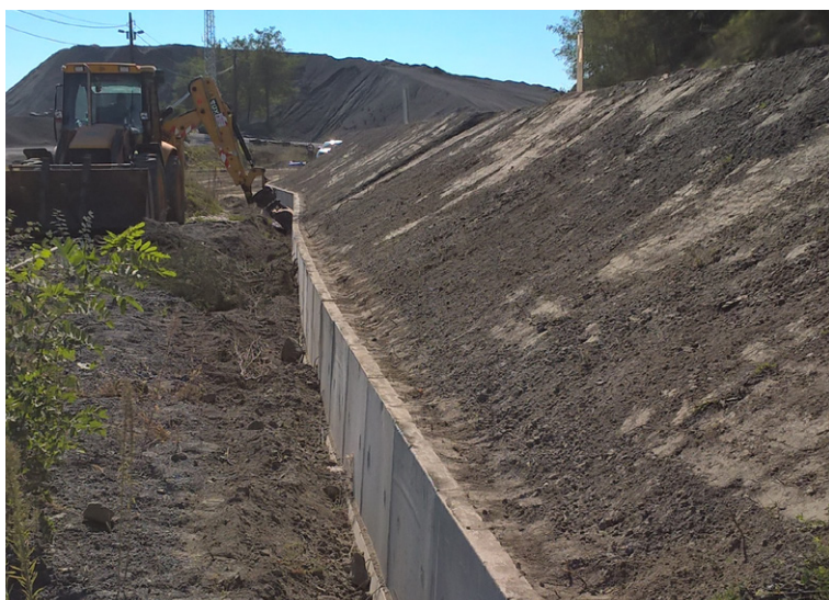
Rézsűszakasz az előkészítő földmunkák után
