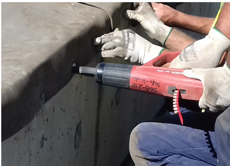
A Mócsán árokelemekhez a CC-t Hilti szögekkel rögzítették
