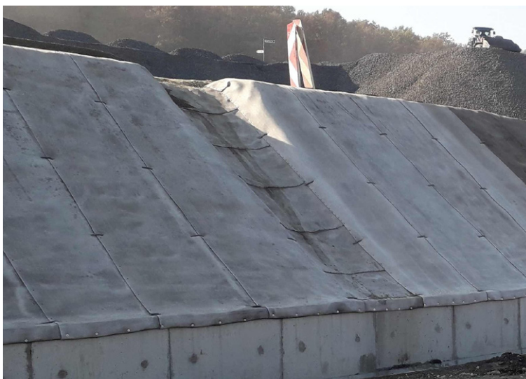
Keresztirányú CC terftékekkel kiépített surrantó
