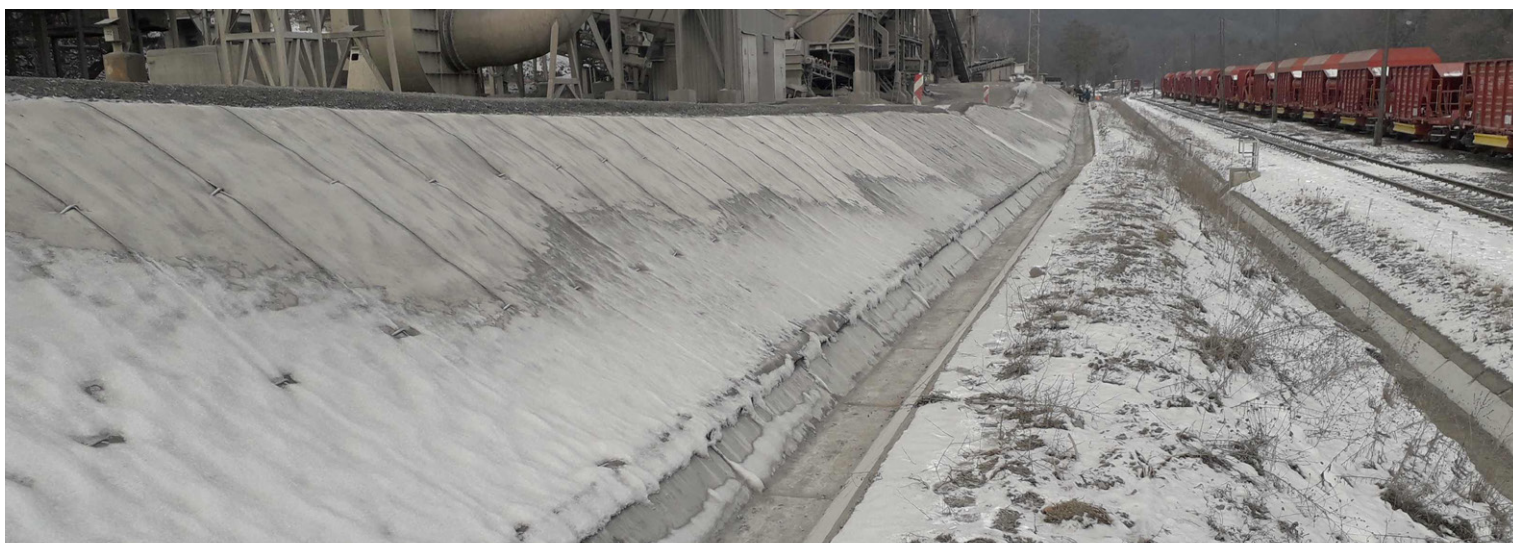
A CC-vel burkolt rézsű ellenáll a téli időszakokban előforduló fagyás-olvadás okozta igénybevételnek
