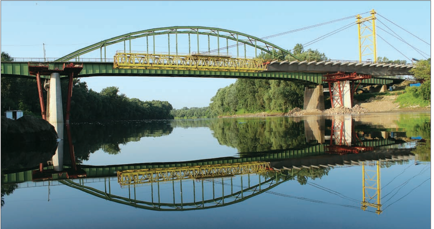
1. kép: Az új vásárosnaményi Tisza-híd acél felszerkezetének tolása a meglévő régi mellett [1]
