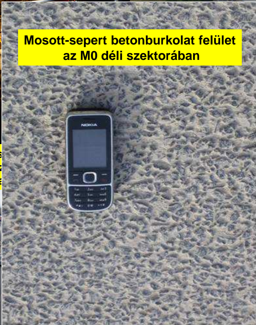
Betonburkolat felületének érdesítő söprése az M0 déli szektorának autópályává bővítése során, 2012.
