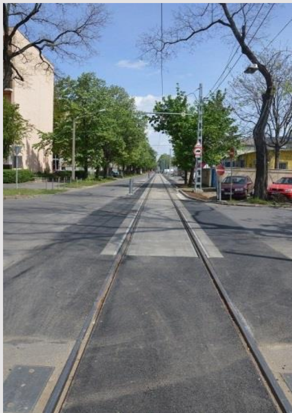
Salétrom utcai ki-bevonuló vágány rekonstrukciója.
