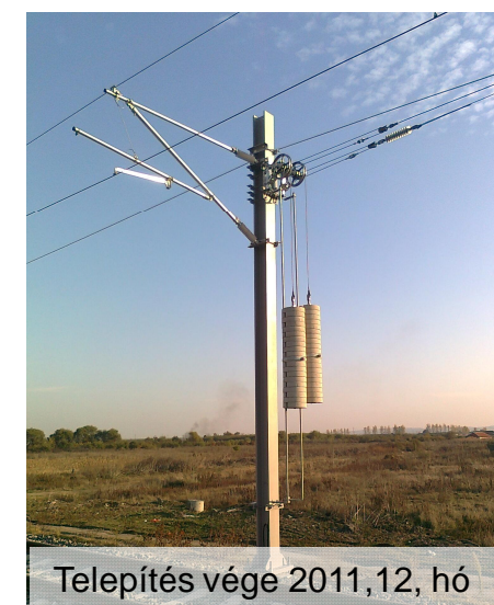
Besajtott csőalapozás a ráültetett acél oszloppal
