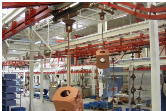
Az építés befejezése, STC indítása
