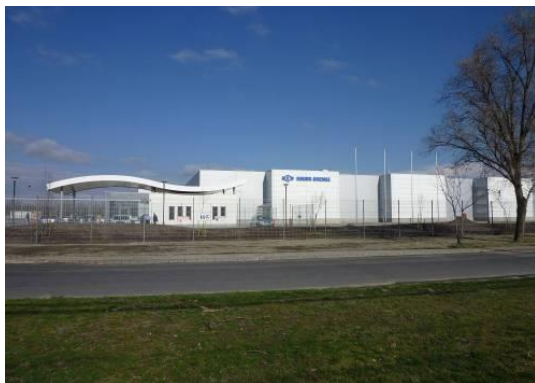
az építés kezdete
