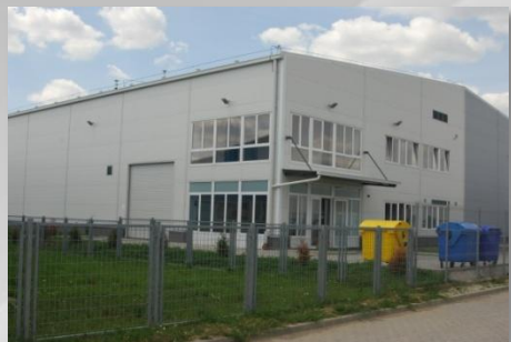
Csokonai Színház kellégyártó műhely
