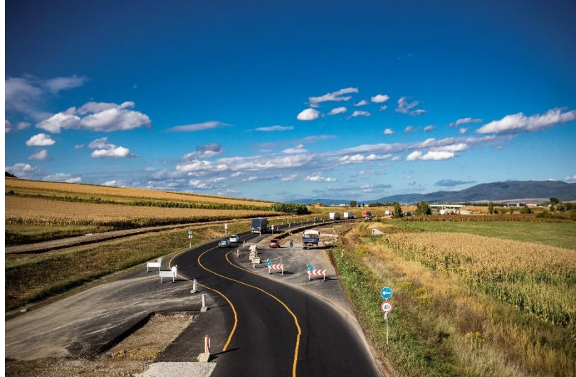
M30 autót Tornyosnémeti – országhatár közötti szakasz megvalósítása
