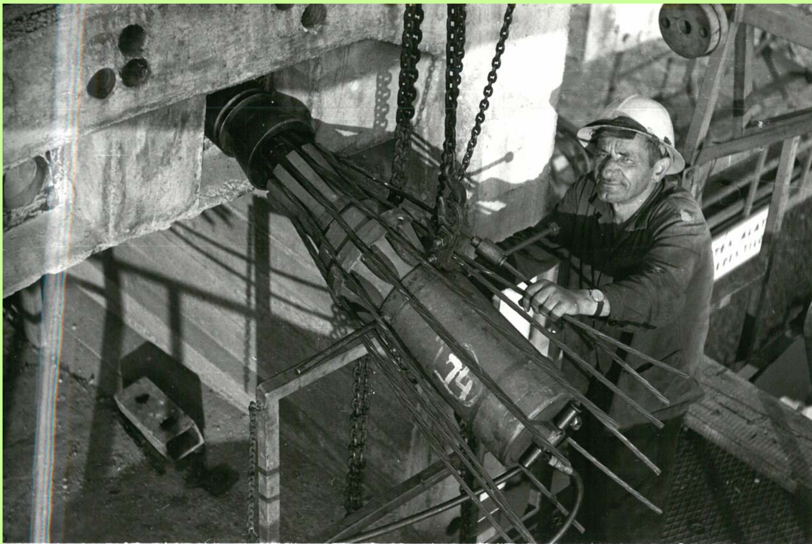
Feszítés Freyssinet feszítő puskával
